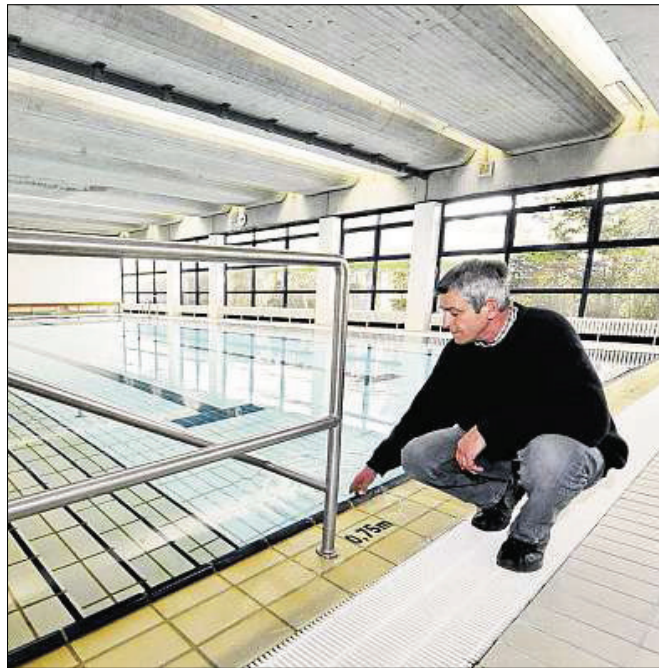
Saubere Sache: Für Hausmeister Josef Groma ist das Schulbecken an der Pestalozzistraße das „schönste Bad der Stadt“. Allerdings ist auch hier eine Modernisierung nötig. Fotos: Rössle
